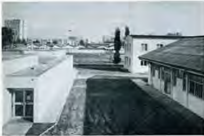
Avant démolition du bâtiment 268
