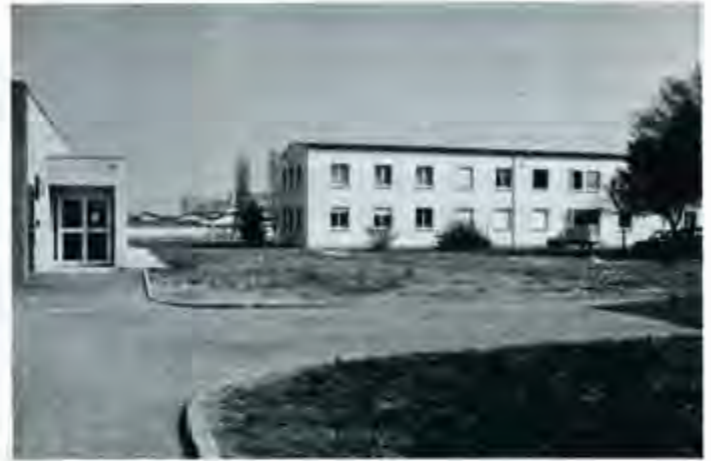
Après démolition du bâtiment 268
